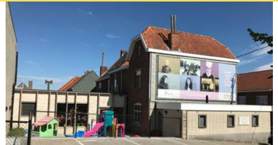
Renovatie buitenschoolse kinderopvang (STA)
