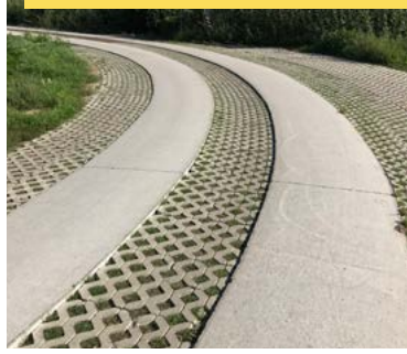
Betonstroken verwerkt in de landbouwwegen
