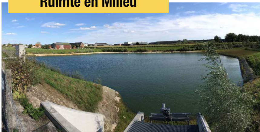
Aanleg bufferbekken (ONK)
