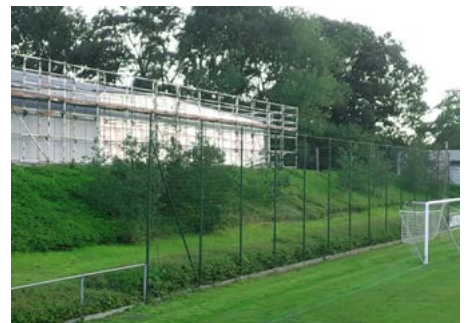
Realisatie buitenschoolse kinderopvang (WRB) en speeltoestellen op site Tiendeberg
