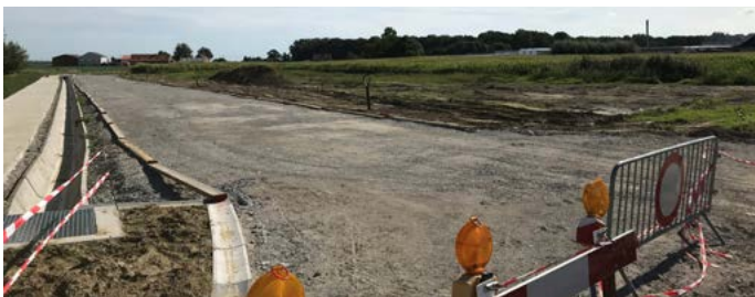
Aanleg nieuwe Romenstraat (WRB) om uitbreiding Greenyard mogelijk te maken
