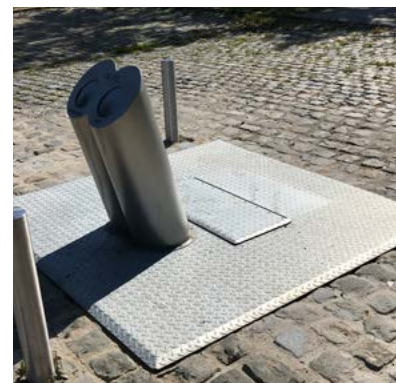
Openbare, ondergrondse glascontainers (WRB, STA en ONK)
