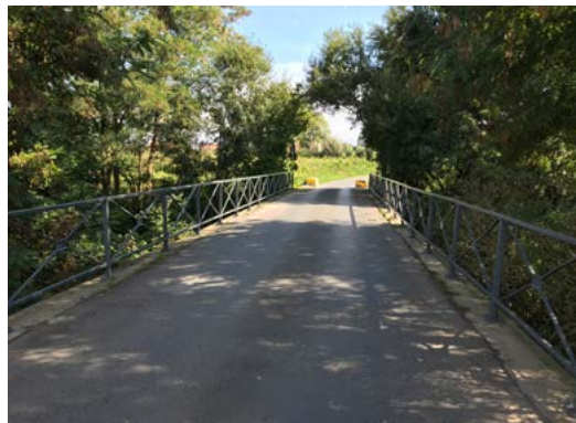
Herstelling brugje Walstraat (STA)
